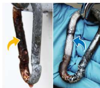
Rust stains on metals Manchas de óxido en metales
